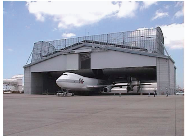
写真1 成田空港にあるエンジン試運転施設 (ハンガー型施設の内部でエンジン試運転を行う。騒音低減能力に優れ、24時間対応の試運転実施が可能になっている。)
