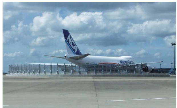
図-2 ブラストフェンス付きエンジン試運転施設
