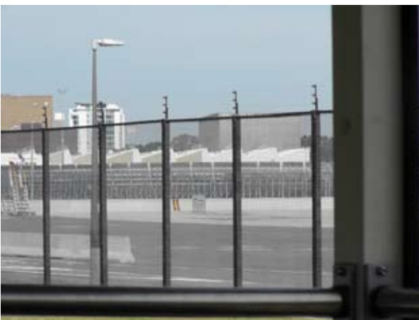
図8 エンジン試運転施設（回転式ブラストフェンス付）
