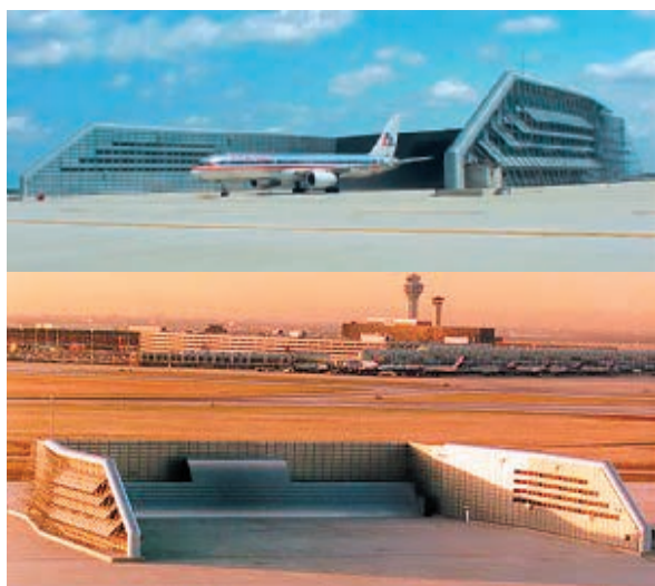
写真2 エンジン試運転用施設(GRE: Ground Run-up Enclosure)
