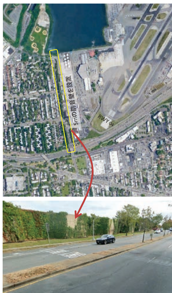
図5 空港南西部敷地境界の防音壁
