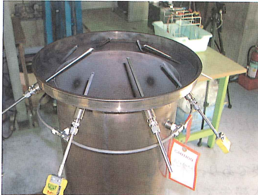
写真-1 排気ダクト（プローブ取付位置）
